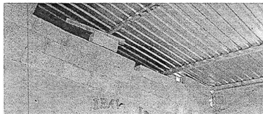
REPARACIÓN DE 15 METROS DE LARGO Y 5 METROS DE ANCHO DE TECHO DE LÁMINA, POR LÁMINA TROQUELADA.
