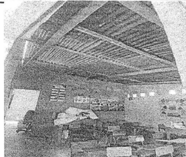
REPARACIÓN DE 15 METROS DE LARGO Y 5 METROS DE ANCHO TECHO
