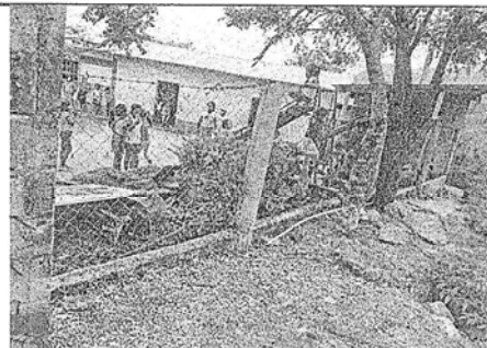
REPARACIÓN DE MURO PERIMTRAL DE 13 METROS LINEALES POR 3 METROS DE ALTO
