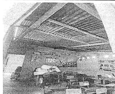
REPARACIÓN DE 15 METROS DE LARGO Y 5 METROS DE ANCHO TECHO
