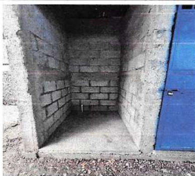
Foto 3: baño y puerta y repello y cernido para los baños
