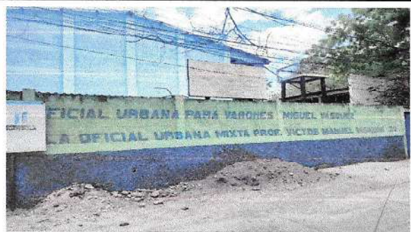
Foto 5: pintura frente muro perimetral
