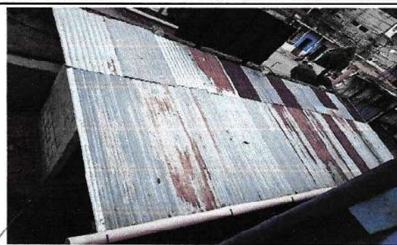
Foto 2: techo de baños
