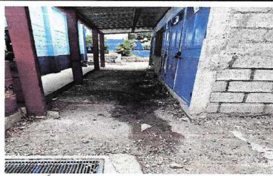
Foto 4: losa de baños y repello y cernido para los baños
