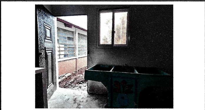
Foto 4: Se instaló pila de cemento de 2 lavaderos con su llave de chorro
