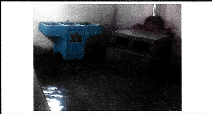
Foto 6: Se mejoró el piso de losa de concreto.
