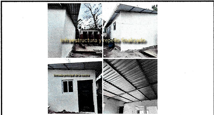
Foto1: Se finalizó cubierta de lámina, canales y bajadas de agua pluvial, repello de paredes e instalación de puertas y ventanas.
