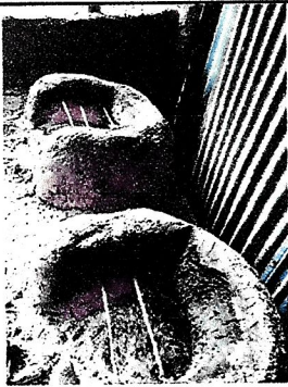
Foto1: Cocina actual que necesita ser remozada.
