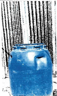
Foto 4: Es el único espacio que funge como pila, se desea sustituir por pila de cemento con dos lavaderos. Se observa el chorro y falta instalación de drenaje
