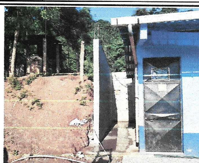
Foto 2: En esta fotografía se puede apreciar el frente de las aulas y el muro de contención que previene el deslave en la parte posterior y al costado
