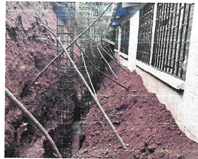
Foto 2: En la imagen se aprecia la preparación del terreno para la fundición de la zapata con las columnas ya colocadas respectivamente.
