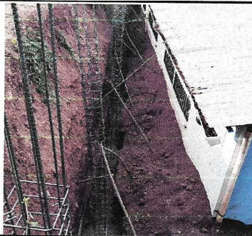
Foto1: En esta fotografía se muestra ya el arranque terminado y las columnas dispuestas en su lugar respectivo.
