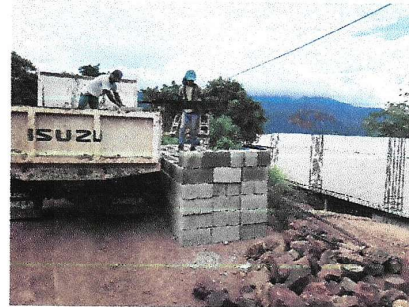
Foto 4: Acá se puede apreciar la llegada de más material para la construcción del muro, al fondo las columnas erguidas.
