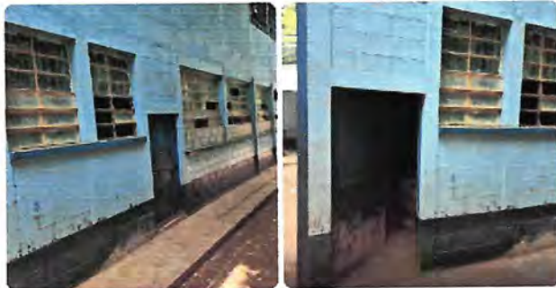
Foto 1: Arreglo de ventanas y colocación de balcones
