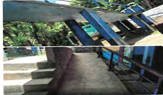
Foto 2: Arreglo de barandas
