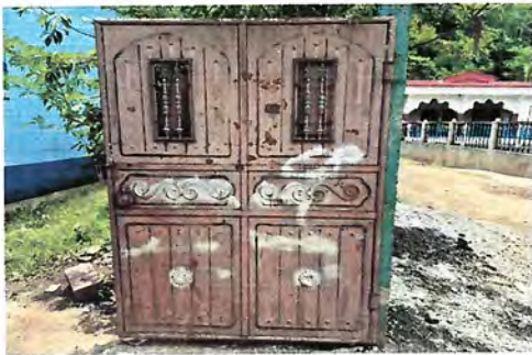
Foto 3: Arreglo de portón
