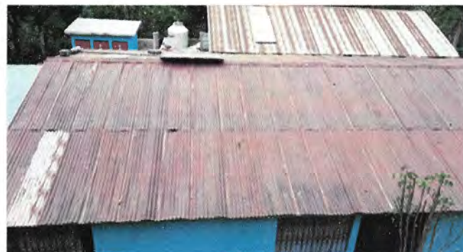
Foto 2: Techo de la escuela
