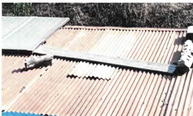
Foto 1: Techo de la escuela
