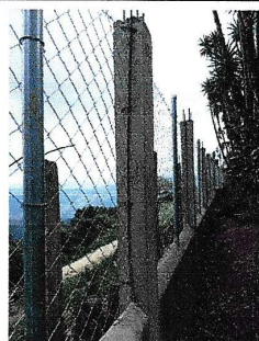
Foto 2: Nuevas columnas intermedias.
