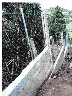
Foto 3: Nueva base de columnas y malla galvanizada.
