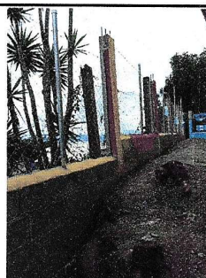
Foto 4: Muro de cuatro hiladas de block con malla.
