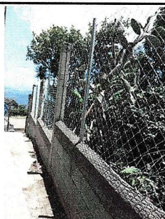
Foto 1: Nueva malla galvanizada.
