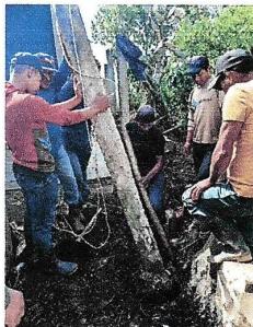
Foto1: Remoción de columna en mal estado.
