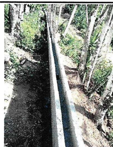
Foto 6: Hilada de block U para fundición de costilla de soporte.
