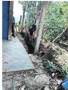
Foto 2: Apertura de sanjo para introducir nuevas columnas intermedias.
