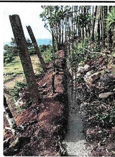
Foto 4: Fundición de viga de humedad de base.
