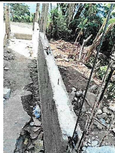
Foto 5: Fundición de viga de humedad sobre cuatro hiladas de block con columna intermedia.
