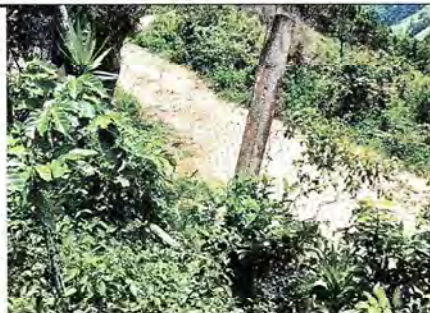
Foto 2: Columnas intermedias en mal estado, torcidas.
