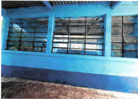
Foto 3: Sustitucion de ventanas en mal estado
