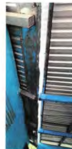
Foto 6: Mantenimiento a canal de bajadas de agua
