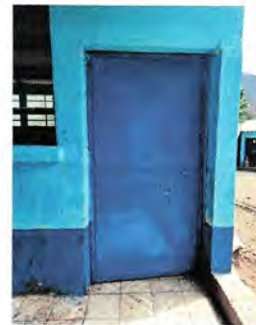
Foto 4: Mantenimiento a puertas
