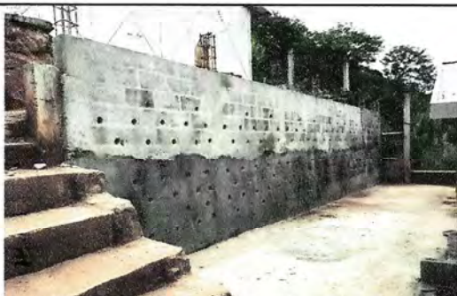
Foto 3: Muro de contención y torta de cemento.
