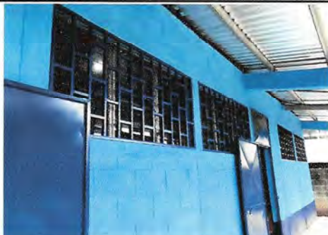
Foto 2: Pintura en muros interiores y exteriores. Lijado y pintado de balcones. Reparado, lijado y pintado de puertas.
