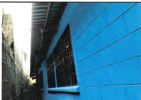
Foto 4: Lijado y pintado de balcones tranceros. Pintura en muros tranceros del establecimiento.
