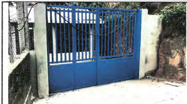
Foto1: Finalización instalación de portón.
