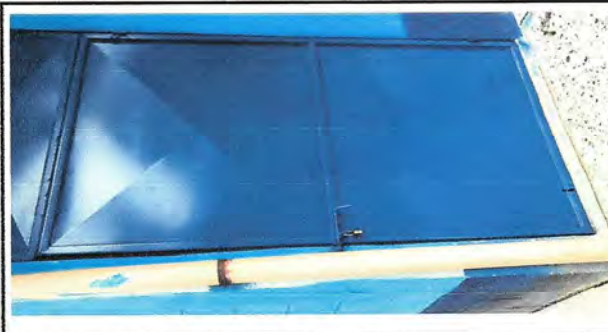
Foto 6: Reparación, lijado y pintura de puertas.
