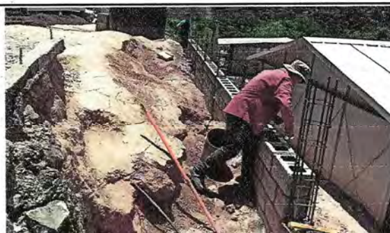
Foto 3: Continuación de muro de contención.
