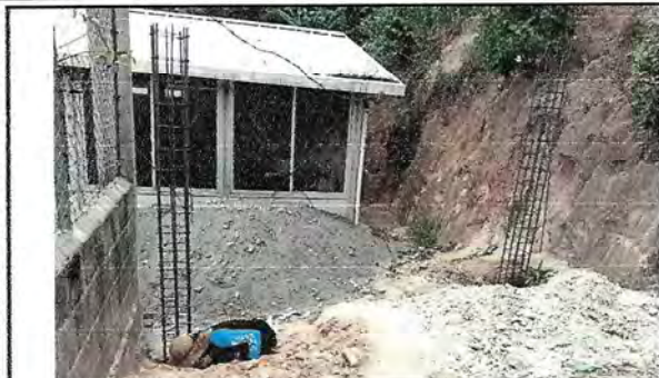
Foto1: Construcción de bases para portón.
