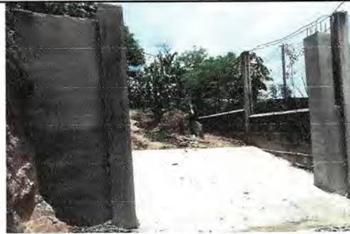
Foto 2: Construcción de bases y torta para portón.
