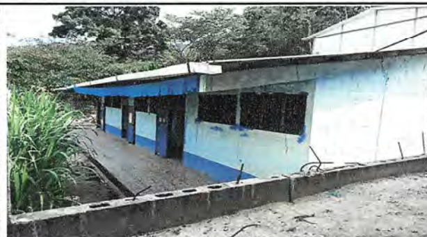
Foto 2: Escuela de block (Pintura para 3 aulas, 3 puertas, 6 balcones delanteros y 6 tranceros).
