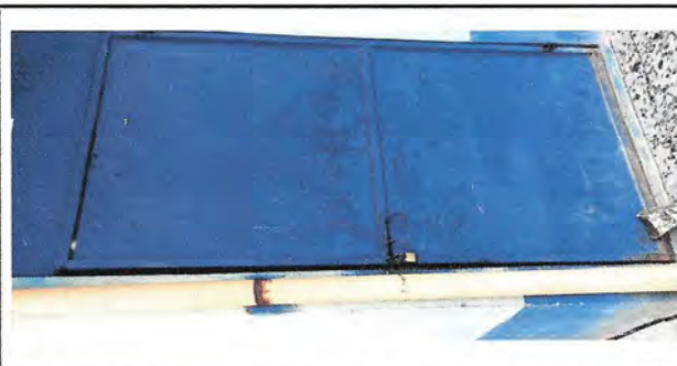
Foto 6: Una de las puertas en mal estado (No cierra porque se produjo un asentamiento diferencial en el terreno).
