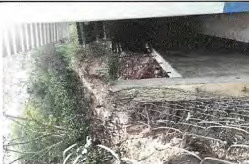
Foto 4: Muro de atrás de los baños.
