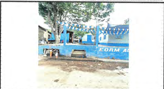
Foto 9: Elaboración de porton para area de rampa
