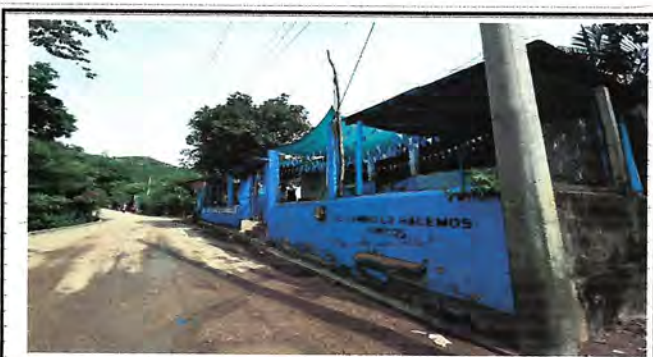
Foto 10: Cambio de malla muro perimetral
