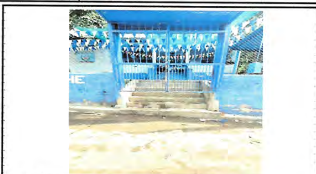
Foto 8: Ampliación de 2 mts. y mantenimiento de portón
