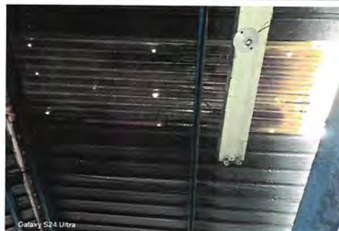
Foto 2: Sustitución de lamina traslucida de plicarbonato
