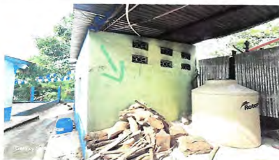
Foto 5: Elaboración de ventana para cocina
