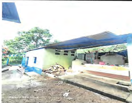
Foto1: Cambio de techo de cocina
