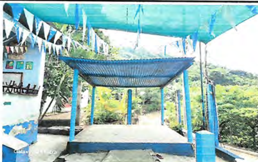
Foto 3: Desmontaje y montaje e ampliación de escenario
