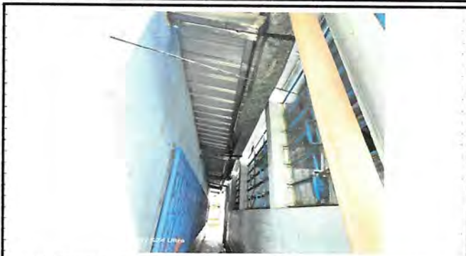
Foto 7: Canal pluvial colocación y sustitución
