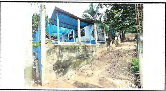
Foto 11: Muro perimetral de block
