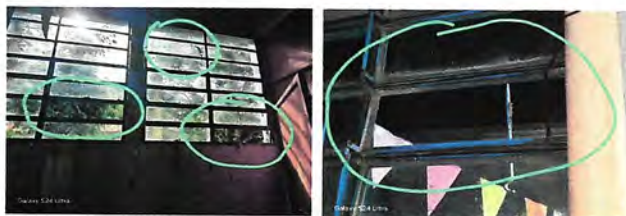
Foto 6: Sustitución de vidrios
