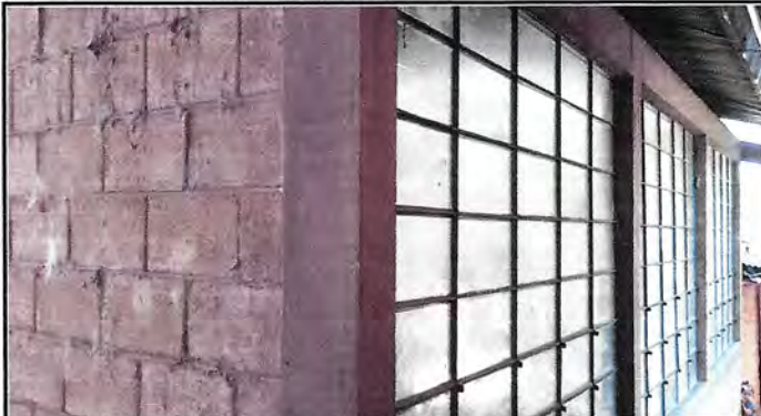
Foto 2: Ventanas y Paredes actuales
