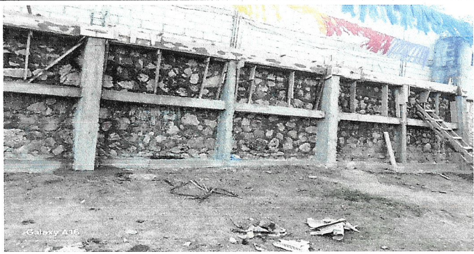
Foto 1: Se evidencia el avance de la parte final de la construcción del muro de contención.
