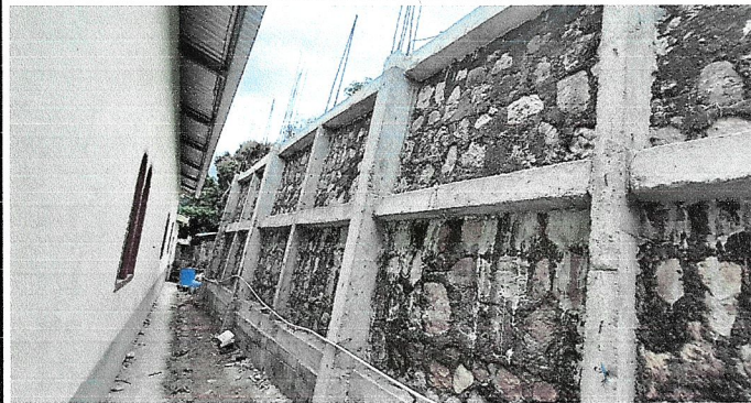
Foto 2: En la imagen se observa la la etapa final del proyecto
