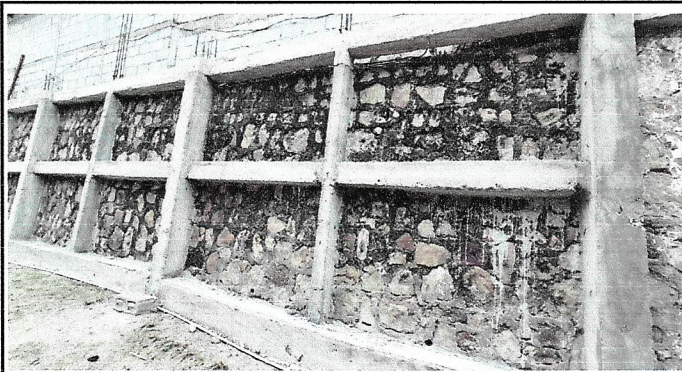
Foto 4: De esa forma se observan las columnas del muro de contencion.
