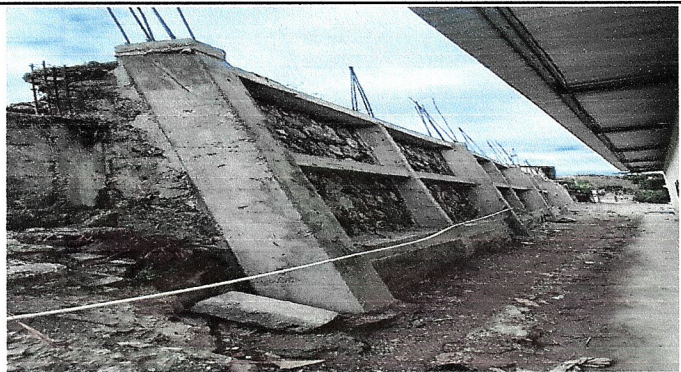
Foto 3: Parte final de la costrucción del muro de contención
