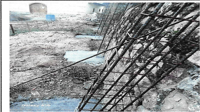
Foto1: Se observa parte del inicio de la construcción del muro.
