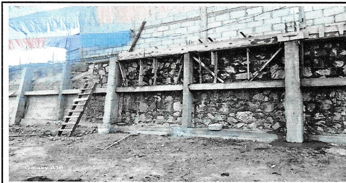
Foto 5: Es muy notorio el avance del proyecto de del muro de contecion con un 80%.
