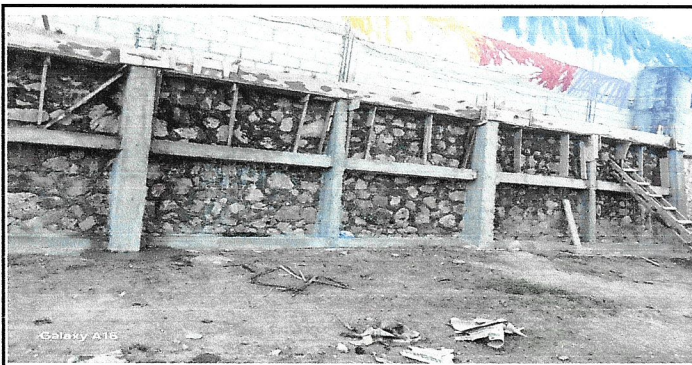
Foto 6: La construcción del muro de contención tiene lleva un 95% de avance, la que sostiene a tres aulas albergando aproximadamente 90 niños estudiantes.
