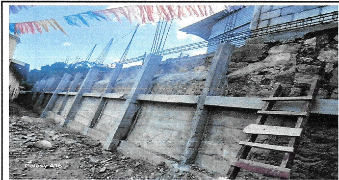
Foto 3: Es evidente el avance del proyecto del muro de contención.
