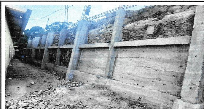
Foto 4: De esta manera se encuentra el muro de contención en pleno avance.
