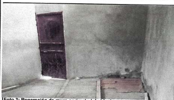
Foto 3: Reparación de muro perimetral de block
