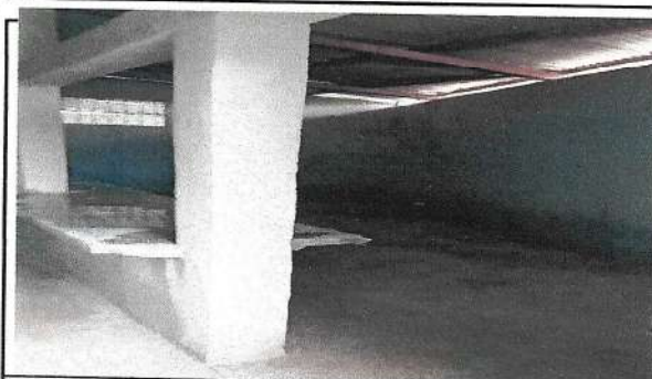
Foto 4: Repello en muro, sellado de grietas.
