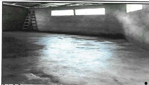
Foto 2: Colocación de Piso de Cemento
