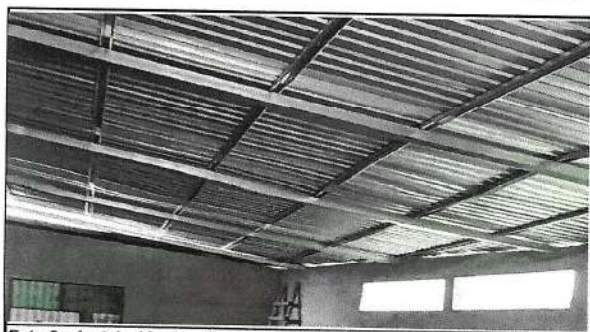
Foto 6: Instalación de estructura metálica
