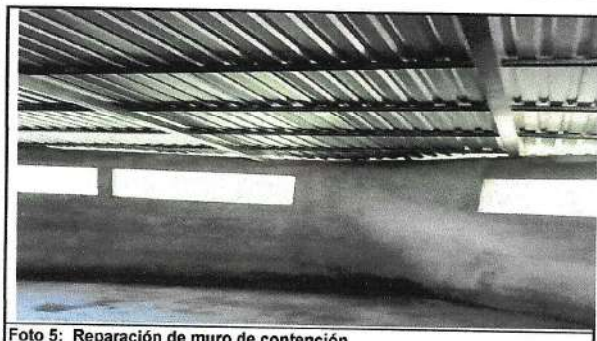
Foto 5: Reparación de muro de contención
