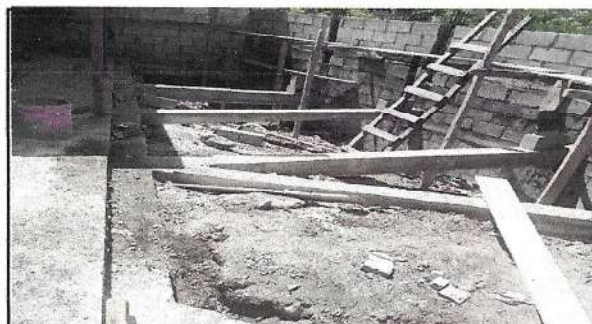
Foto 5: Reparación de muro de contención
