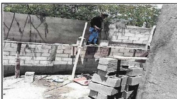
Foto 4: Repello en muro, sellado de grietas.
