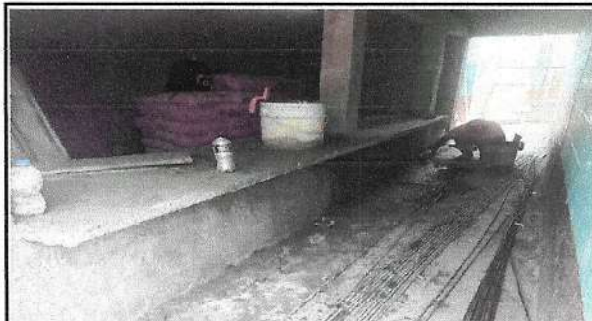
Foto 1: Sustitución de Puerta
