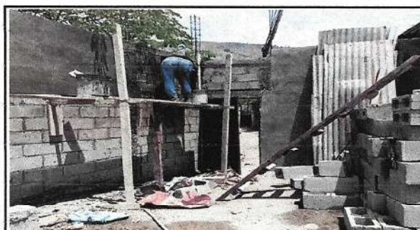
Foto 3: Reparación de muro perimetral de block
