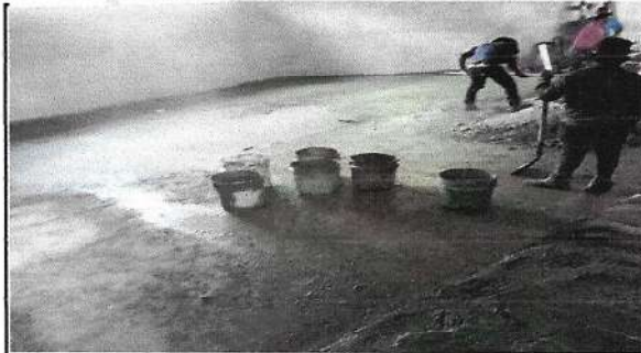
Foto 2: Colocación de Piso de Cemento
