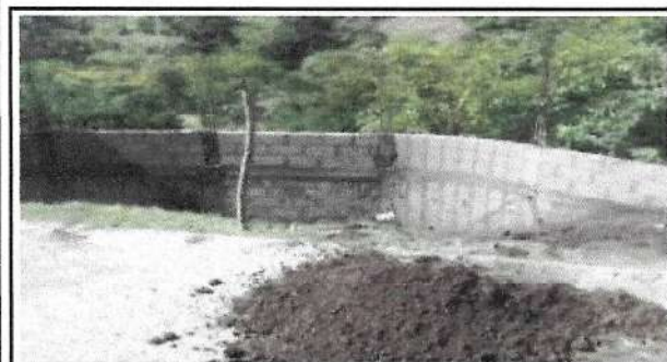
Foto 3: Reparación de muro perimetral de block
