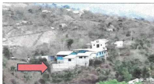
Foto 6: Reparación de muro de contención
