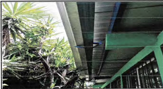
Reparación de canal
