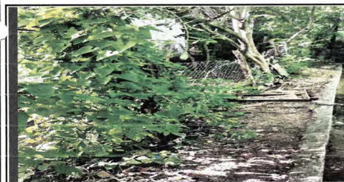
Sustitución de muro perimetral
