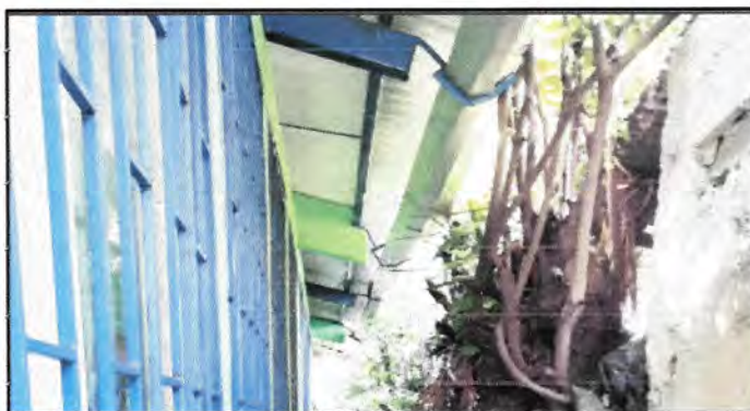
Sustitución de soporte de canal
