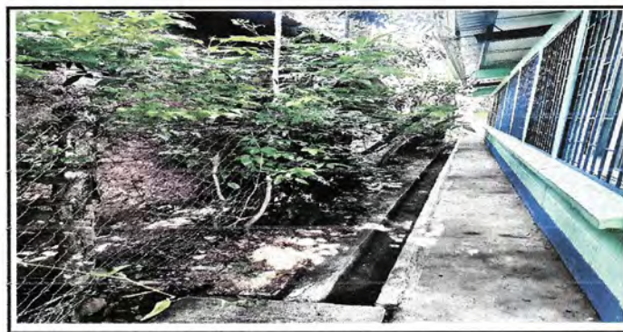
Sustitución de muro perimetral
