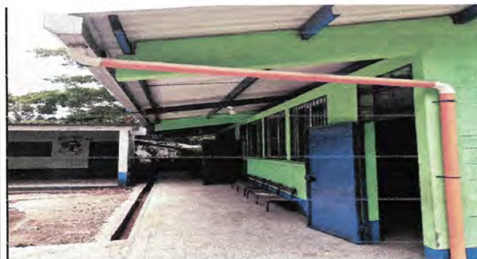
Reparación de bajada de agua tubo PVC
