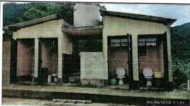
Foto 4: Sustitución de puertas en servicios sanitarios
