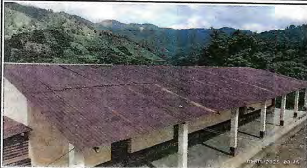
Foto1: Sustitución de lámina, por lámina troquelada aluzinc
