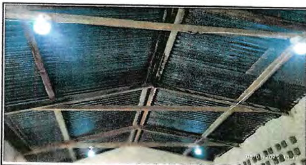
Foto 6: Reparación de cableado eléctrico
