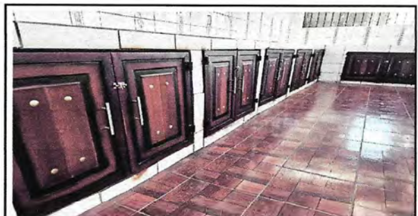
Sustitución de puertas de gabinete finalizado
