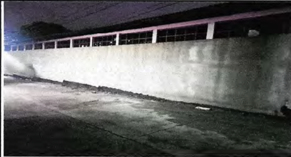
Reparación de muro perimetral de block finalizado
