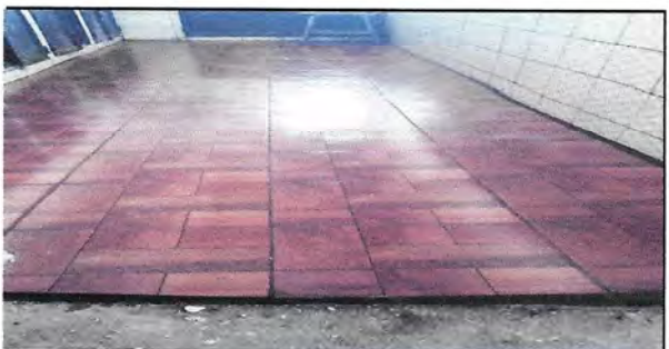
Instalación de cerámico en cocina finalizado
