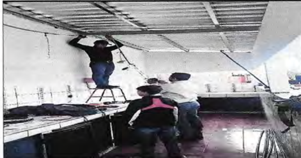
Reparación sistema eléctrico en proceso
