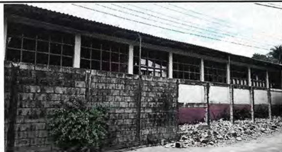
Reparación de muro perimetral de block en proceso
