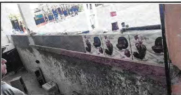
Instalación de azulejo en cocina en proceso
