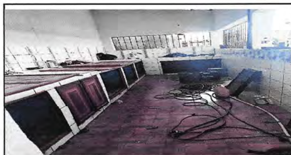
Sustitución de puertas de gabinete en proceso
