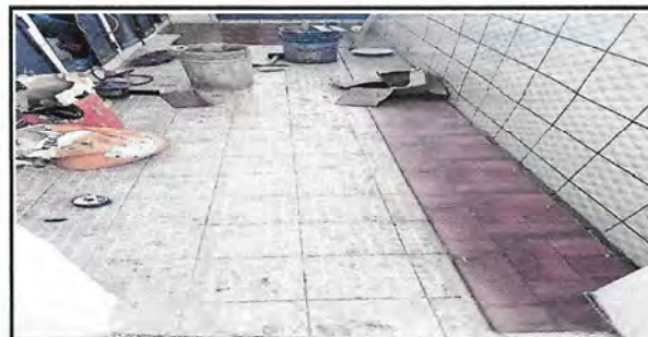
Instalación de cerámico en cocina en proceso
