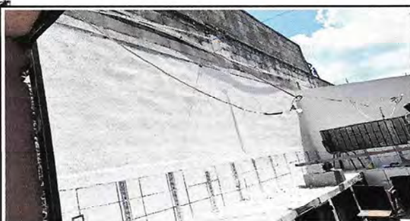
Cernido en muro de cocina en proceso
