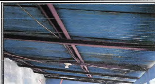
Reparación sistema electrico
