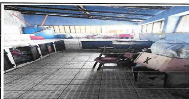
Instalación de cerámico en cocina.
