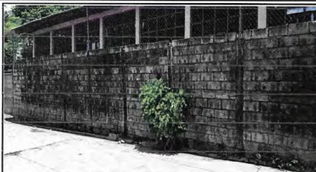
Reparación de muro perimetral de block
