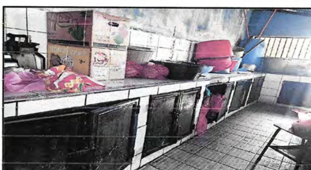
Sustitución de puertas de gabinetes
