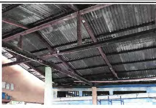
Foto 2: otro ángulo del techo que se pretende remozar con estructura metálica
