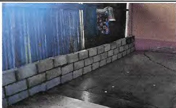
Foto 5: Muro perimetral que se va a remozar.
