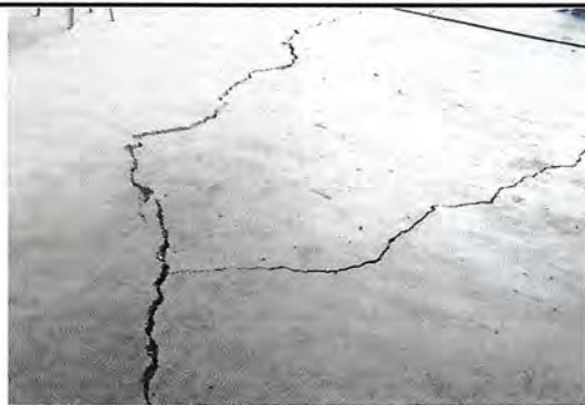
Foto 4: otra sección del piso de concreto que se va a remozar
