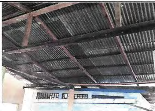
Foto1: Techo de lamina de zinc que se pretende remozar
