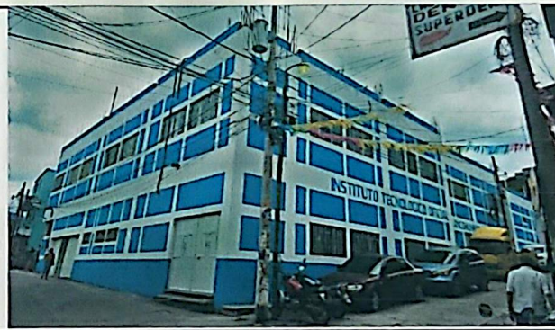
Foto 4: 9.1 Pintura de muros exteriores e interiores.
