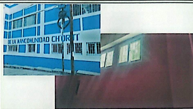
Foto 2: 5. Sustitución de ventanas por paredes.5. Sustitución de pared por ventanas.
