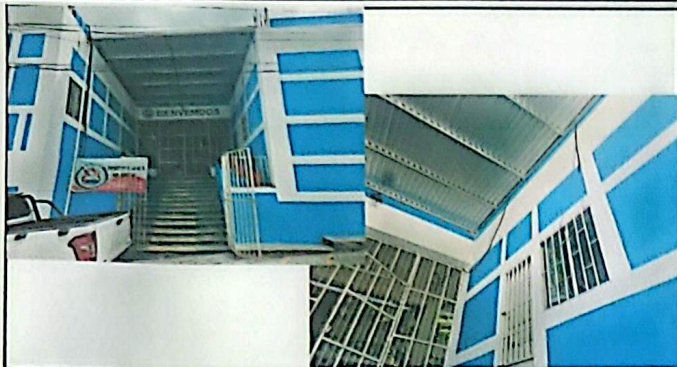
Foto1: 2. Estructura de techo. Sustitución por estructura metálica.
