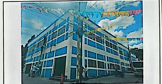
Foto 4: 9.1 Pintura de muros exteriores e interiores.
