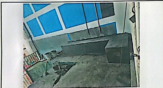
Foto 3: 8. Reparación de Cuneta de concreto.
