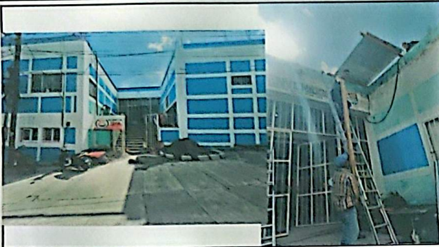
Foto 1: 2. Estructura de techo. Sustitución por estructura metálica.
