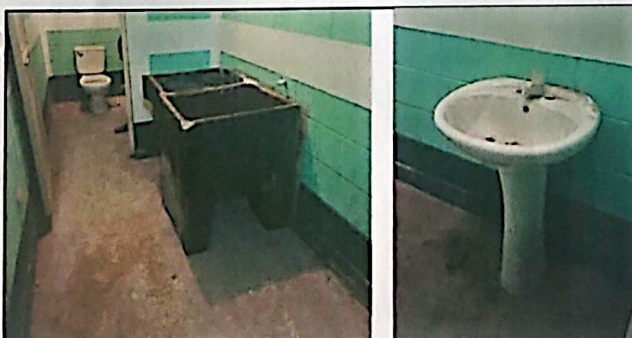
Foto 5: 10.3 Sustitución de inodoro. 10.5 Sustitución de Lavamanos. 10.12 Sustitución de Pila, por pila plástica de 1 lavadero.
