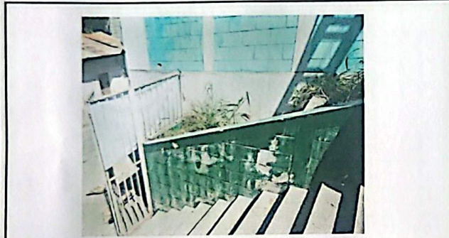
Foto 3: 8. Reparación de Cuneta de concreto.
