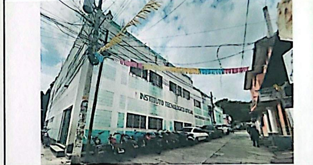
Foto 4: 9.1 Pintura de muros exteriores e interiores.
