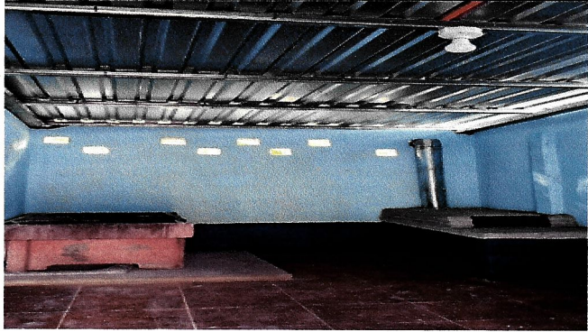
Foto1: se realizó el cambio de soporte de madera por estructura de metal, se instalo la lámina alucinc troquelada y se arregló la instalación eléctrica.
