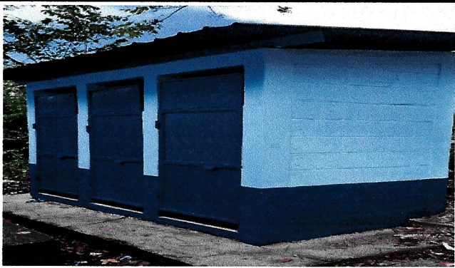
Foto 2: se realizó el mantenimiento a los sanitarios.
