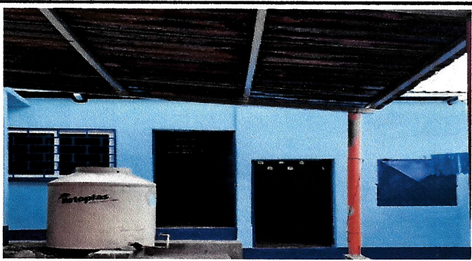
Foto 6: Sustitución de losa de cocina y de salón de clases.
