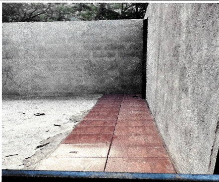
Foto 4: SE ESTA PEGANDO EL PISO CEMICO SOBRE LA NUEVA TORTA DE CMENTO EN EL SALÓN DE CLASES.
