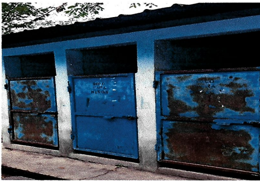
Foto 2: SE ESTA DANDO MANTENIMIENTO A LAS PUERTAS DE LOS SANITARIOS.
