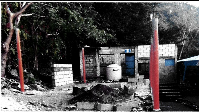
Foto 6: SE ESTA REALIZANDO LA SUSTITUCIÓN DE LOSA DE CEMENTO EN COCINA Y DSALÓN DE CLASES
