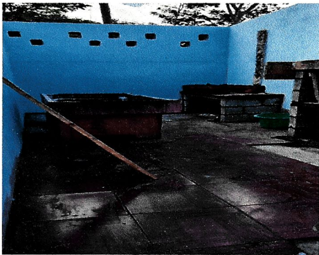
Foto1: SE ESTA REALIZANDO ELCAMBIO DE TECHO Y SU SOPORTE
