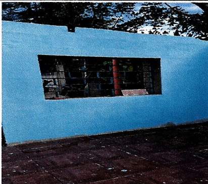
Foto 5: SE ESTA REALIZANDO LA SUSTITUCIÓN DE LA VENTANA EN EL SALÓN DE CLASES.
