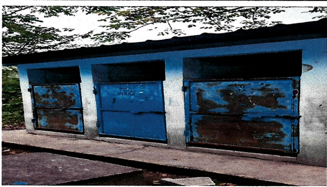
Foto 2: Se realizará lijado y cambio de pintura a las puertas y pintura general de paredes de los baños
