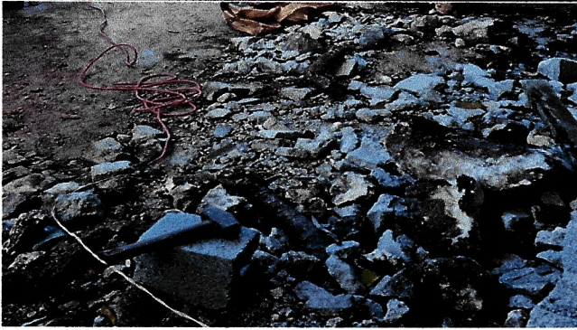
Foto 6: Sustitución de losa de cocina y de salón de clases.
