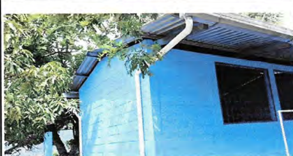
Foto 4: Así quedó la instalacion de estructura y techo
