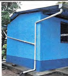
Foto 5: Así quedó la Instalación de Canales y bajada de agua Pluvial
