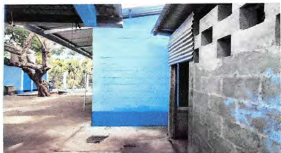
Foto 1: Seguimiento de Paredes de aula finalizado
