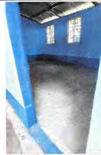
Foto 6: Fundición de losa de Patio (torta de cemento) finalizado.
