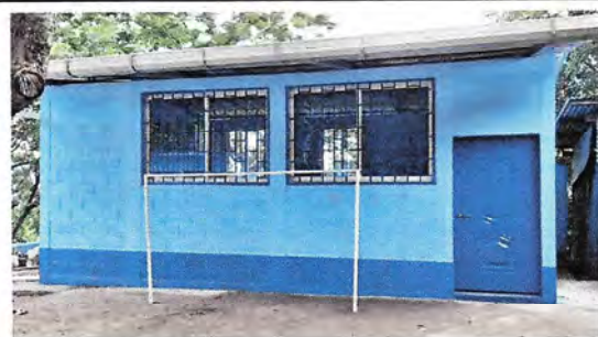
Foto 3: Instalación de Ventanas pvc Finalizado
