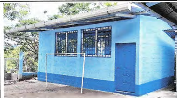
Foto 2: Instalación de Puerta y balcones finalizado
