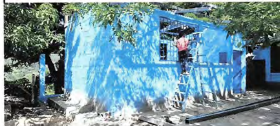
Foto 6: Instalacion de Puerta y Balcones
