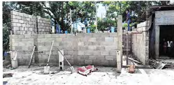
Foto1: Seguimineto de Paredes de aula
