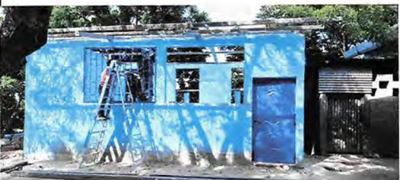
Foto 5: Instalacion de Puerta y balcones
