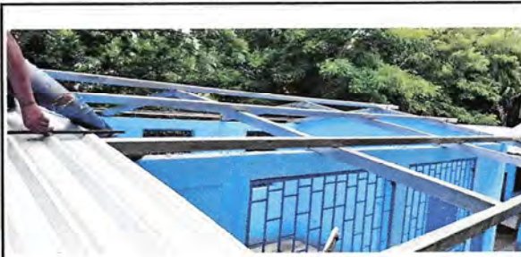
Foto 2: Instalación de estructura y techo
