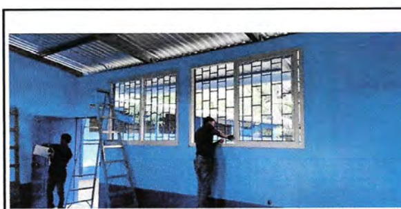
Foto 5: Instalación de Ventana pvc
