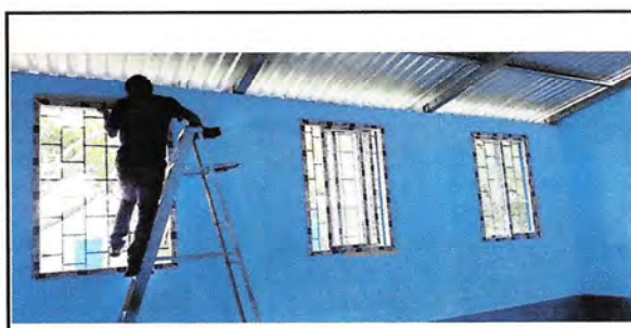
Foto 6: Instalación de Ventana pvc
