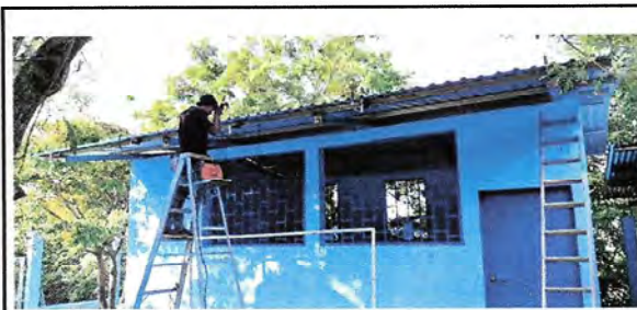
Foto:3 Instalacion de Canales
