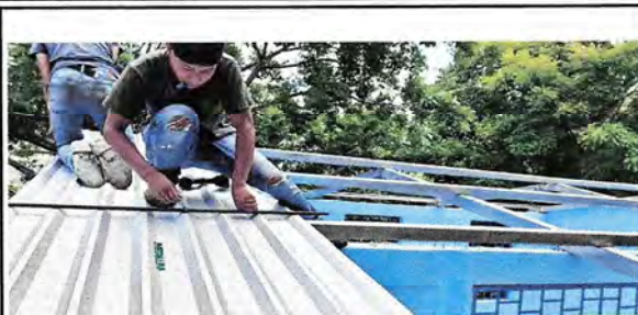
Foto1: Instalación de Estructura y techo
