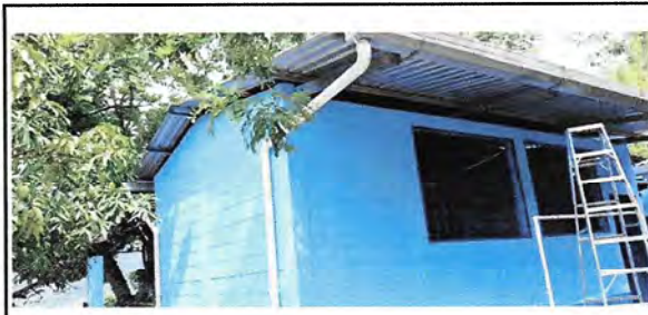
Foto 4: Instalación de Canales
