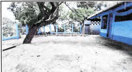
Foto 1: Frente del aula a remozar
