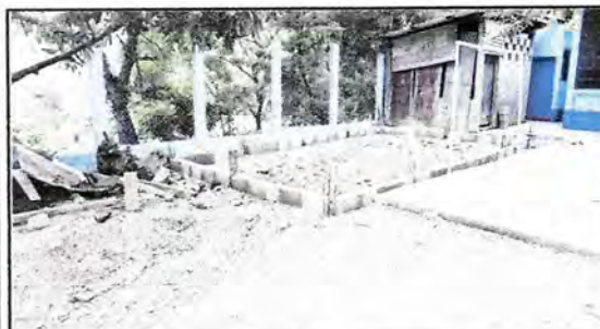
Foto 3: Esquina de aula por los baños.
