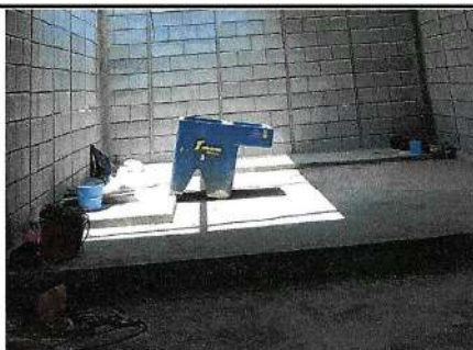
Foto 9: Instalacion en drenaje de pila y chimenea de estufa de leña para el area de cocina.
