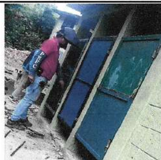
Foto 4: Puertas sustituidas y reconstruidas para area de Sanitarios
