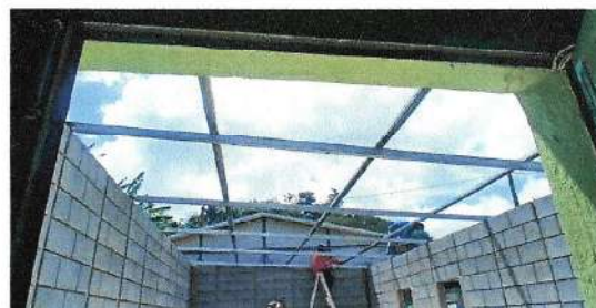
Foto 6: Area de Cocina y Comedor Instalacion de estructura metalica y lamina.
