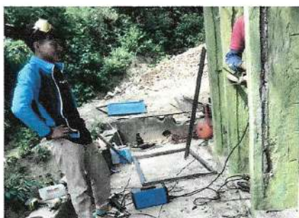
Foto 3: Area de Sanitarios Reparacion de Puertas
