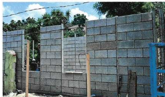
Foto 2: Area de Comedor y cocina, Paredes de Brocon ya formadas reforzando esquinas con columnas.
