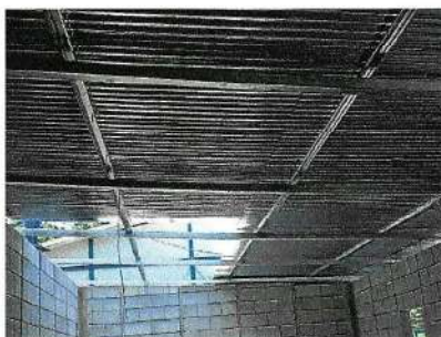
Foto 7: Area de Cocina Entechado con laminas acanaladas.
