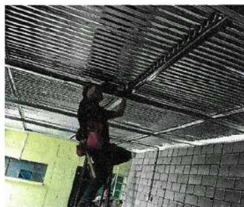
Foto 8: Instalacion de Energia electrica en area de comedor y cocina.
