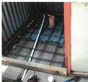
Foto 5: Area de Sanitarios Fundicion de drenajes de sanitarios lavables.
