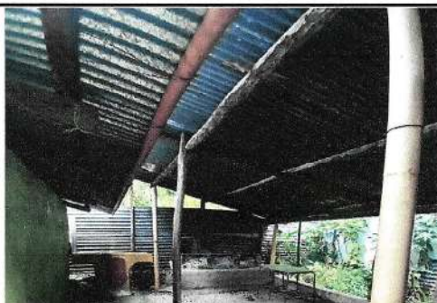
Foto 3: Area de Cocina por la parte de adentro.
