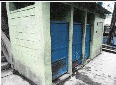
Foto 5: Puertas de sanitarios
