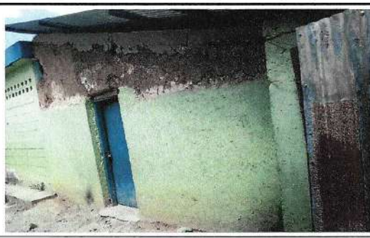
Foto 4: Paredes del area de comedor.
