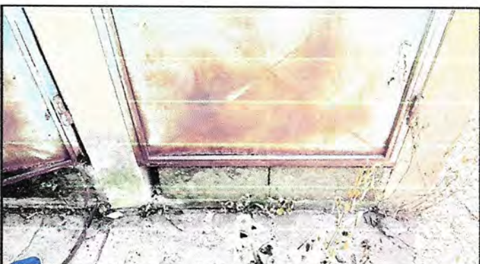
MANTENIMIENTO LIJADO, CEPILLADO Y APLIACION DE PINTURA A 7 PUERTAS DE METAL
