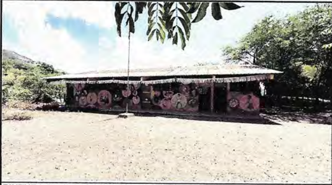
PINTURA EN MUROS INTERIORES Y EXTERIORES
