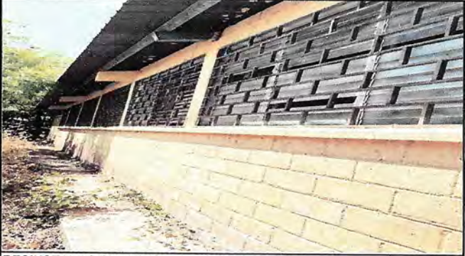
DESINSTALACION DE 10 VENTANAS DE VIDRIO
