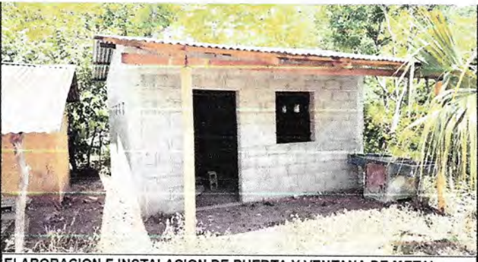
ELABORACION E INSTALACION DE PUERTA Y VENTANA DE METAL PARA COCINA
