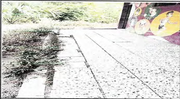
SUSTITUCION DE 38 METROS DE PISO DE GRANITO EN CORREDOR
