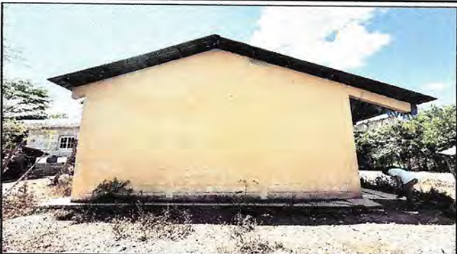
PINTURA EN MUROS INTERIORES Y EXTERIORES
