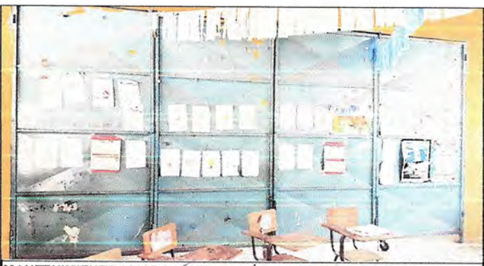
MANTENIMIENTO LIJADO Y APLICACIÓN DE PINTURA A 2 TABIQUES DE METAL
