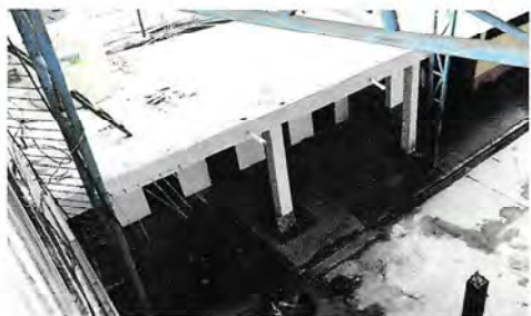
Foto 1: Sustrucción de techo sanitarios.
