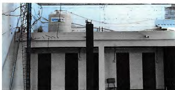
Foto 5: Sustruccin de tuveria principal.
