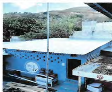
Foto 2: Sustrucción techo direccin.
