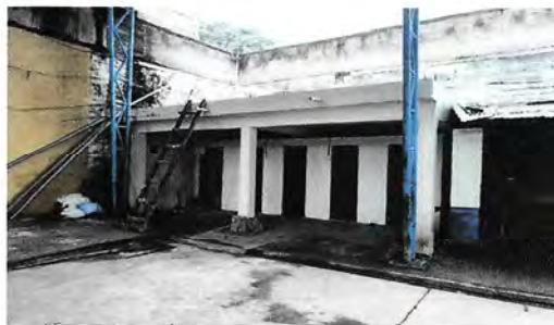
Foto 4: Sustruccin de sanitarios y techado.
