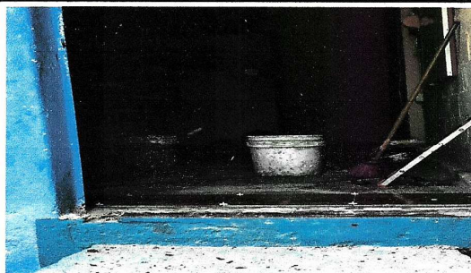
Foto 3: Sustitución de piso de dirección.
