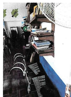
Foto 6: Reparación de pared de dirección.
