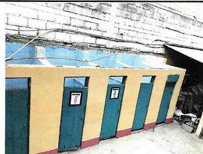
Foto 4: Sustitución de sanitarios y techado.
