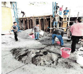
Foto 1: Sustitución de techo sanitarios.
