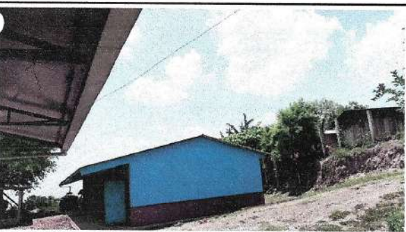
Foto 5: exteriores de las paredes de la escuela ya pintadas.
