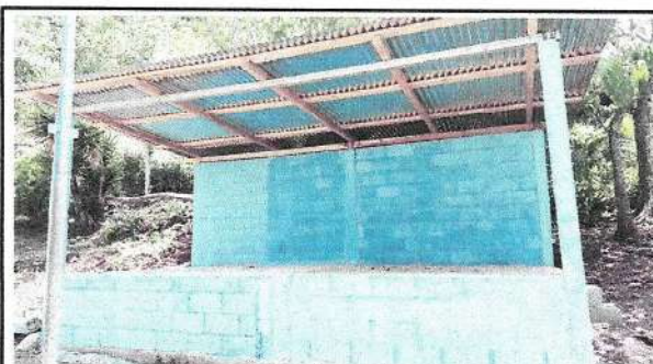
Foto 4: así se ven los trabajos finalizados en area del escenario, se aplico pintura para recubrir el block y proteger
