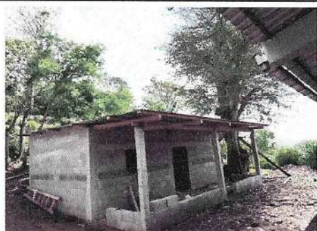
Foto 1: avance de finalización de los trabajos de cocina escolar, se reforzaron los muros y se mejoro la cubierta de techo con estructura portante
