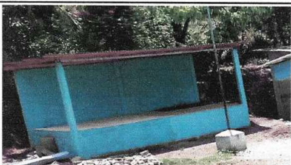
Foto 3: avances de los trabajos, se remodelo la cubierta de lamina y estructura de techo
