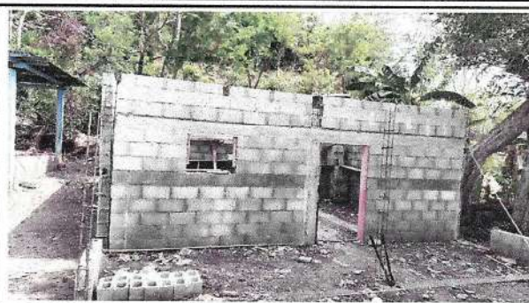
Foto 2: lado frontal de la cocina en donde se esta reforzando las columnas de las esquina
