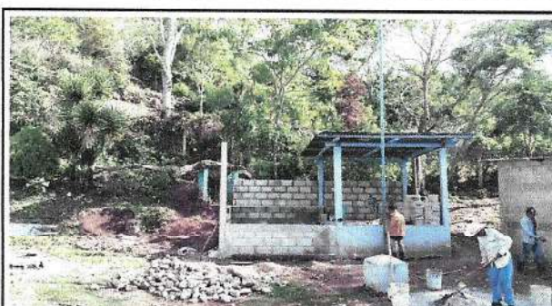
Foto 4: avances en los trabajos de refuerzo del escenario, refuerzo lateral y trasero
