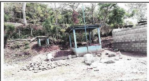
Foto 3: trabajos de refuerzo a la estructura existente en area de escenario.
