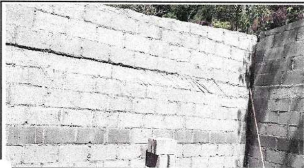
Foto 1: en el proceso de refuerzo de estructura de la cocina, se refuerza vigas y columna sobre las paredes existentes
