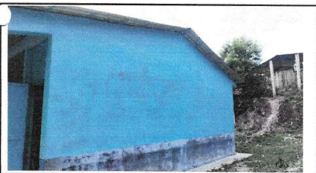
Foto 5: avances de la aplicación de la pintura en paredes exteriores del centro educativo.
