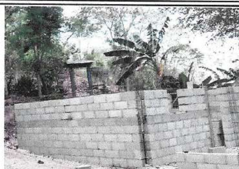
Foto 2: otro ángulo de como con la ayuda de los padres de familia se avanza en la remodelación de la cocina escolar del establecimiento.
