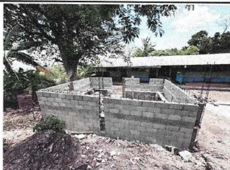
Foto 1: con ayuda y apoyo de padres de familia se realizaron los trabajos previos, como lo fue el arranque y levantado de paredes, para el área de la cocina para contar con espacio digno para la preparación de los alimentos de
