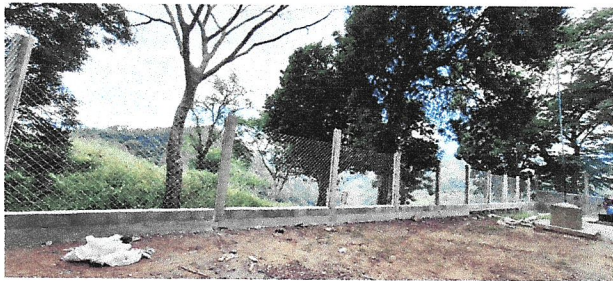
Foto 2: MURO DE CONTENCIÓN
