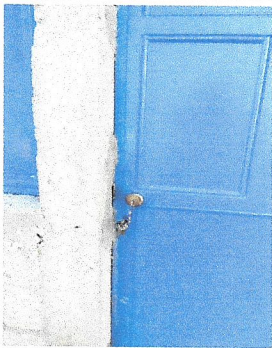
Foto 4: PAREDES DE COCINA
