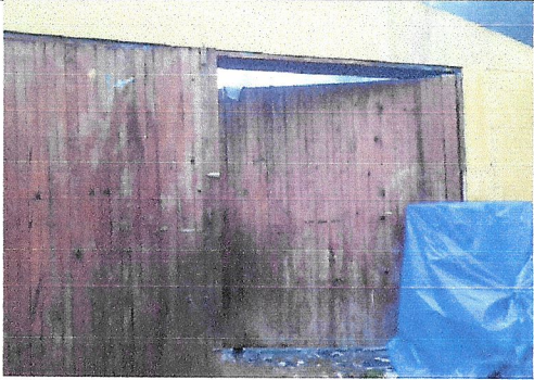
Foto 1: SUSTITUCIÓN DE CANCEL DE MADERA POR PORTÓN DE METAL PARA DIVISIÓN DE UN SALÓN DE CLASES
