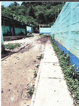
Foto 2: REMOCIÓN DE PATIO DE RECREACIÓN CON LOZA DE CONCRETO
