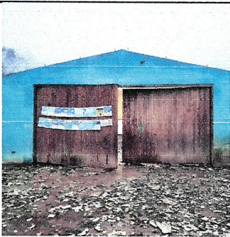
Foto 5: SUSTITUCIÓN DE CANCEL DE MADERA POR PORTÓN DE METAL PARA DIVISIÓN DE UN SALÓN DE CLASES
