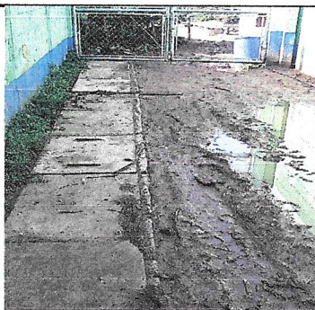
Foto 6: REMOCIÓN DE PATIO DE RECREACIÓN CON LOZA DE CONCRETO
