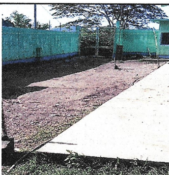
Foto 4: REMOCIÓN DE PATIO DE RECREACIÓN CON LOZA DE CONCRETO
