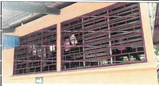
Foto 1: CAMBIO DE VENTANALES POR VENTANAS PVC CORREDIZAS
