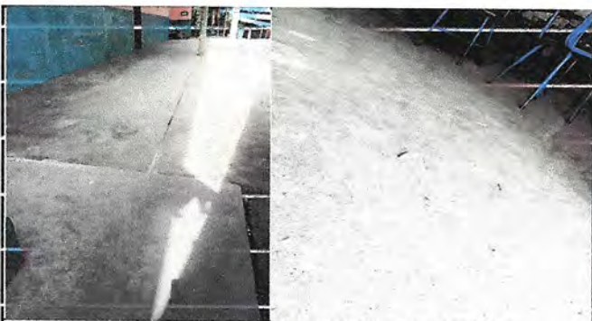
Foto 5: CAMBIO DE TORTA DE CEMENTO POR PISO CERÁMICO
