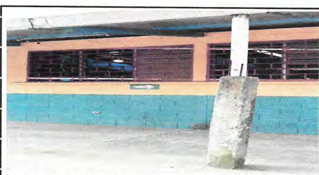
Foto 6: SUSTITUCIÓN DE COLUMNA
