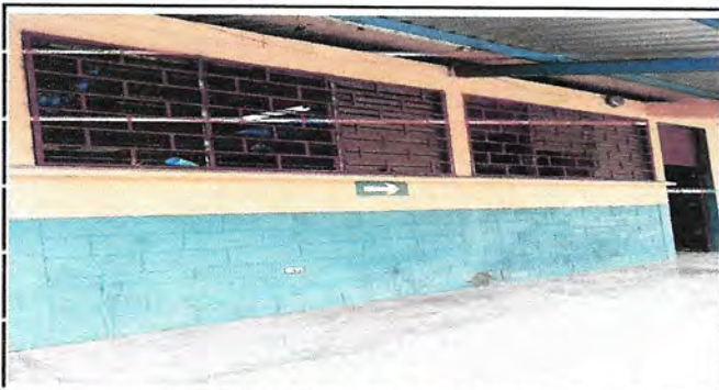
Foto 3: CAMBIO DE VENTANALES POR VENTANAS PVC CORREDIZAS
