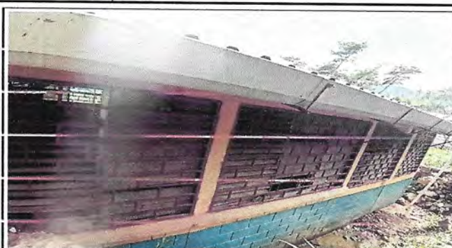
Foto 2: CAMBIO DE VENTANALES POR VENTANAS PVC CORREDIZAS
